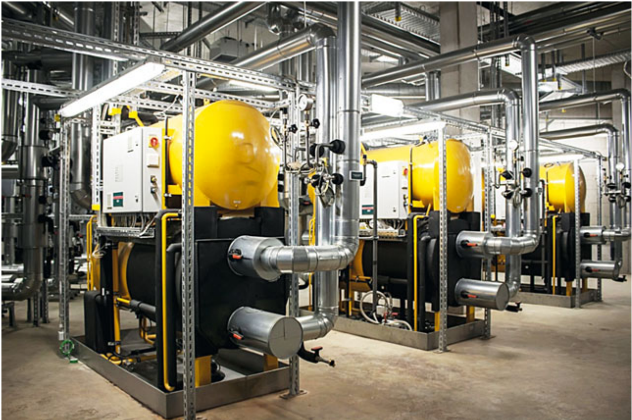
Abbildung 1: AKA-Verbund, bestehend aus drei Anlagen vom Typ „Hummel“
