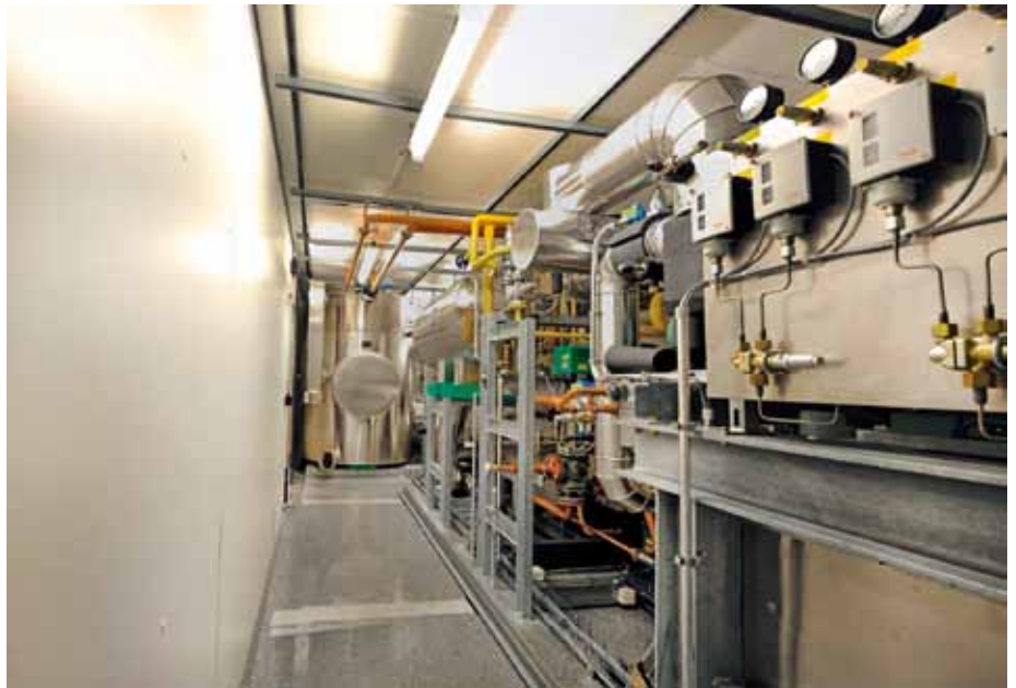
Der Maschinenraum innerhalb des Kältecontainers
