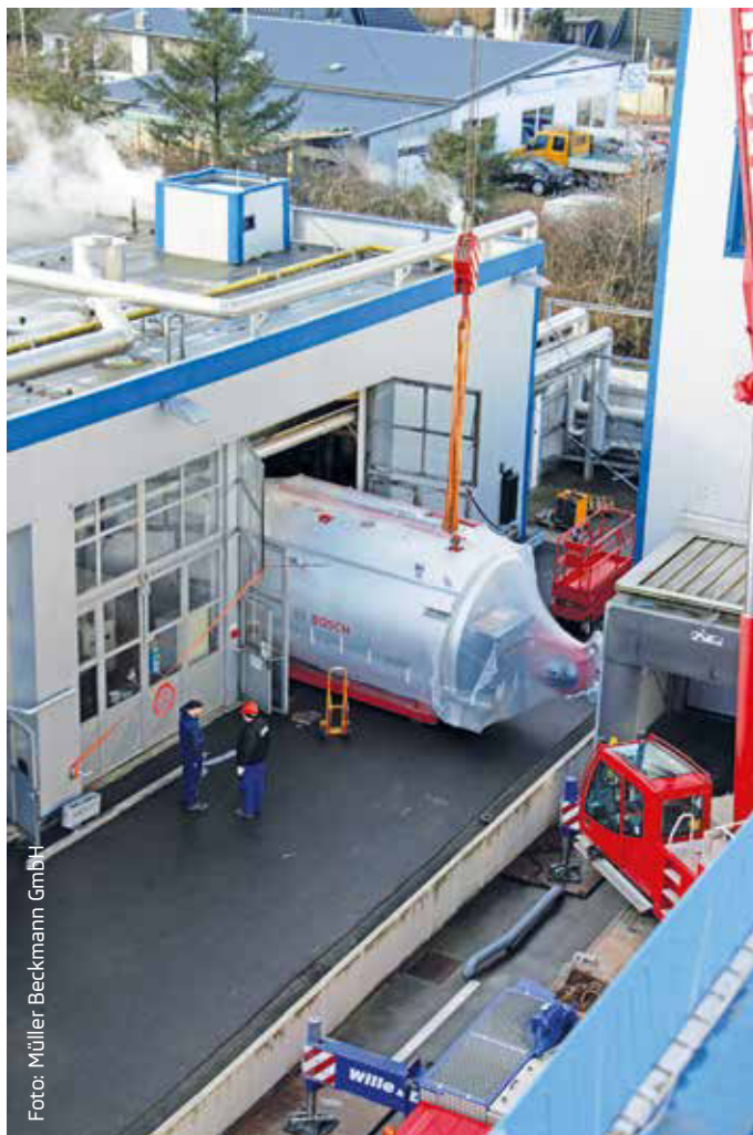
Abbildung 3: Einbringen des Hochdruck-Dampfkessels
