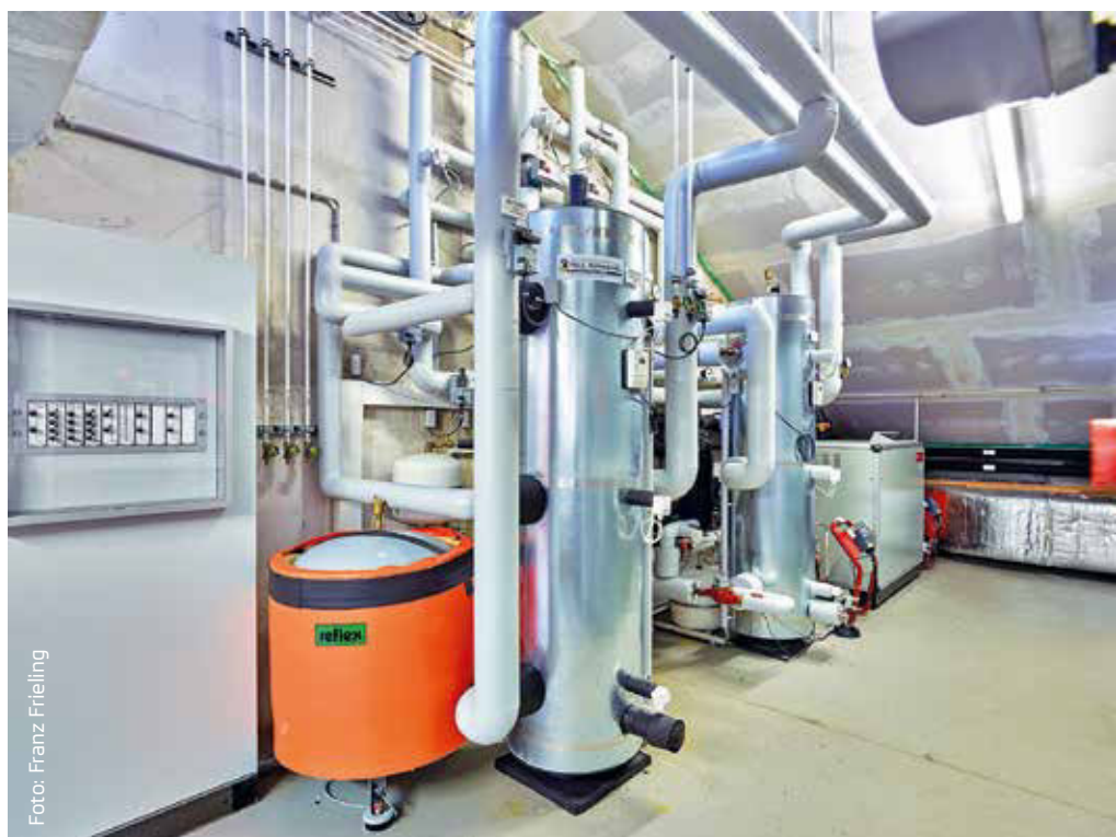
Abbildung 1: Die zwei Hydraulikzentren „Sinus MultiFlow Center“ der Bürgerhalle Wettringen
