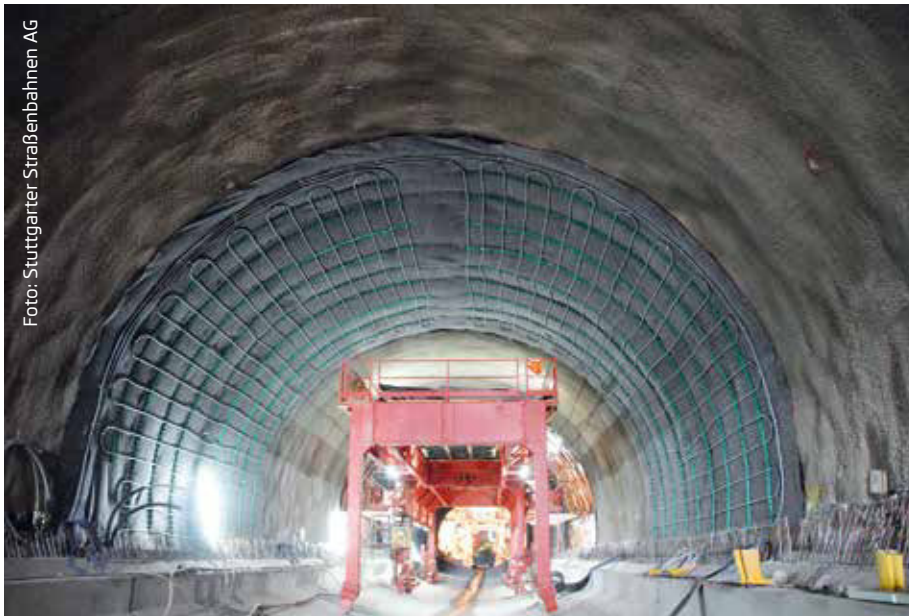
Abbildung 2: Tunnelsektion mit Tunnelabsorber vor der Betonierung
