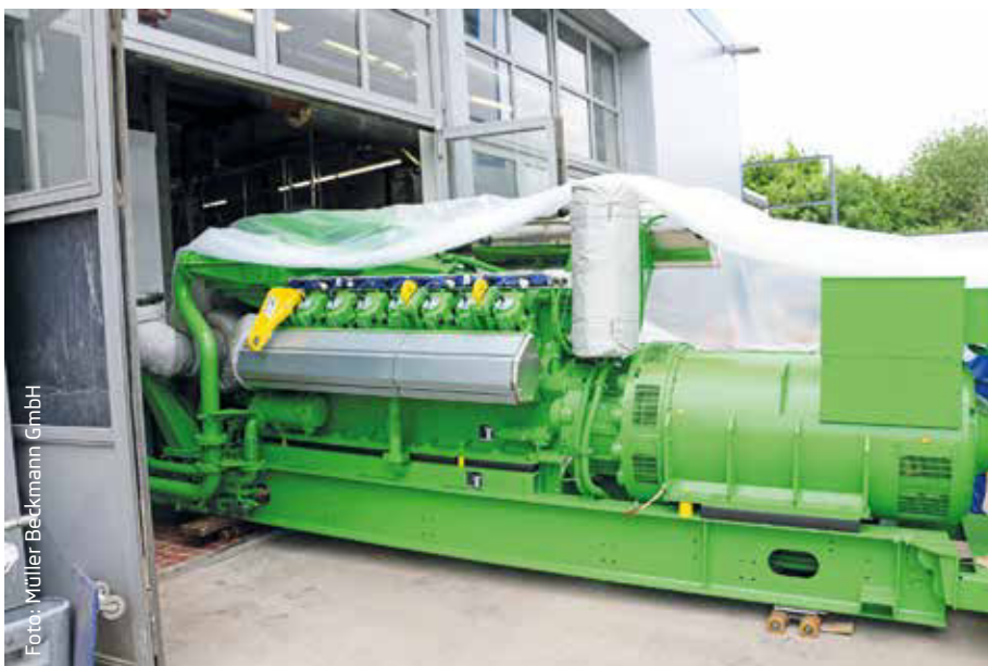
Abbildung 2: Einbringen des Erdgas-BHKW
