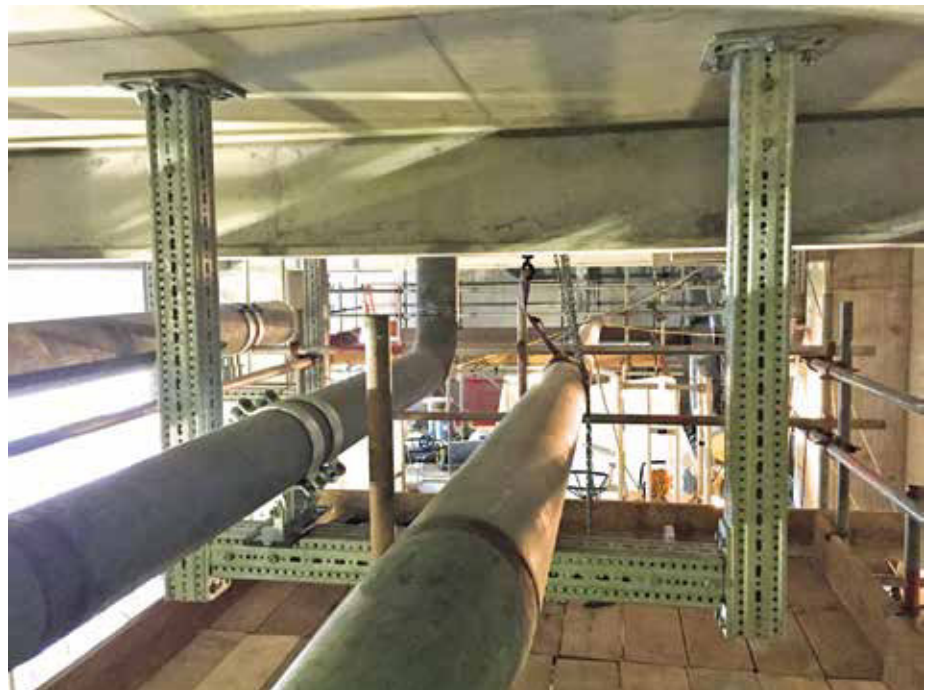
Abbildung 2: Zweidimensionale typische U-Jochkonstruktion
