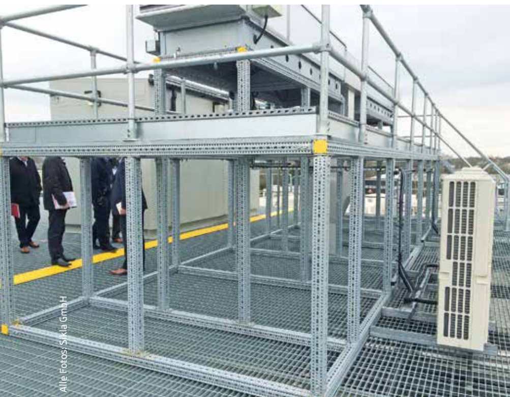
Abbildung 1: Unterkonstruktion für Aggregate
