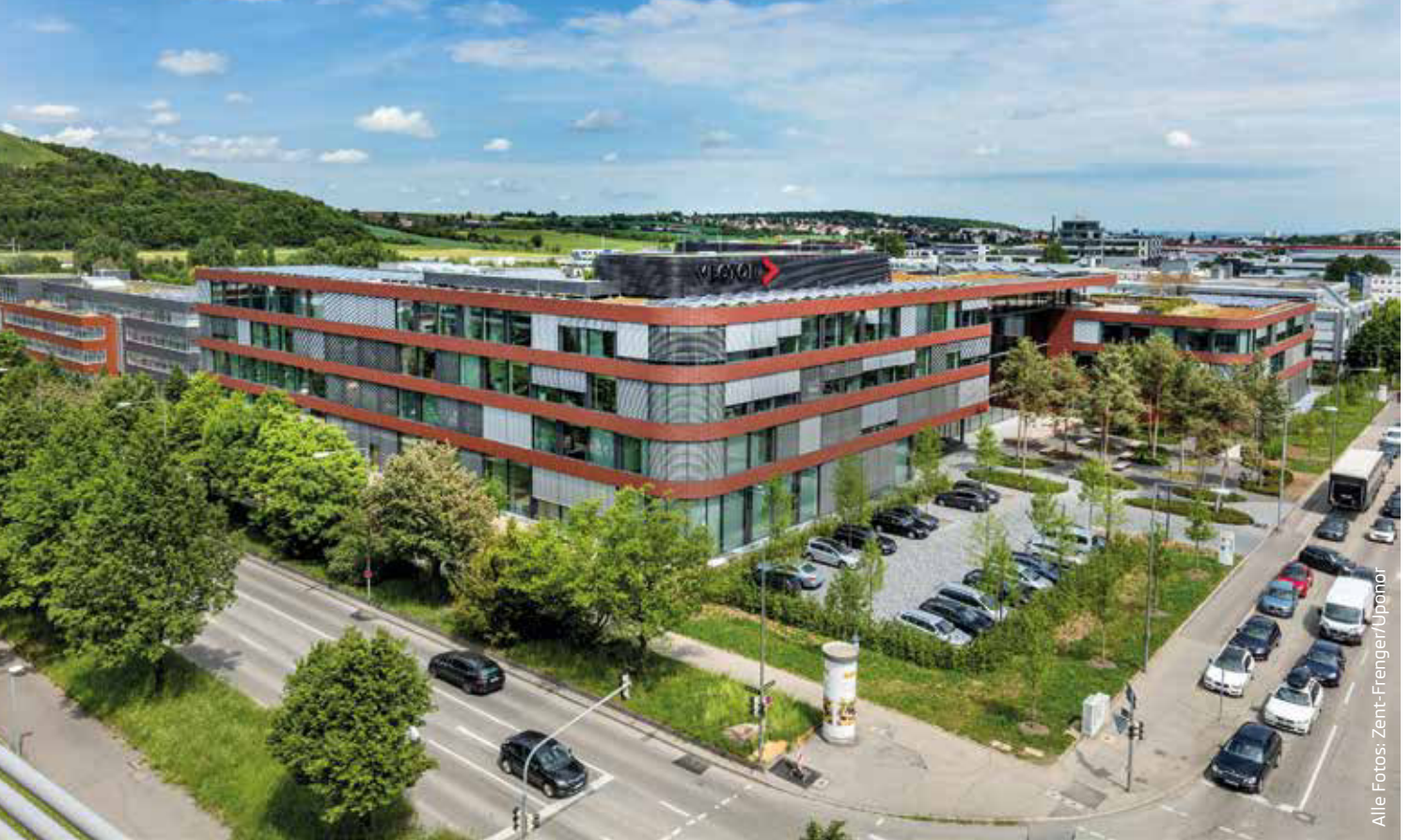
Das neue Verwaltungsgebäude der Vector Informatik GmbH in Stuttgart-Weilimdorf
