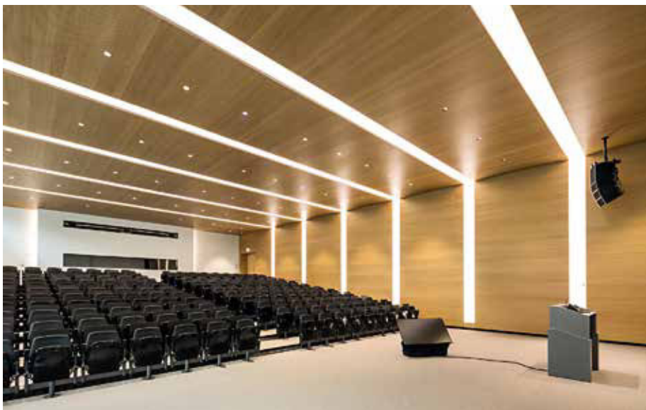
Im Auditorium sorgt eine 500 m 2 große Heiz- und Kühldecke in Holzoptik für angenehme Temperaturen.
