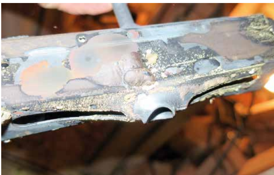
Abbildung 4: Deformierte Rückenlochung einer Montageschiene nach Brandversuch
