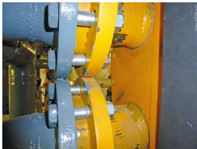
Abbildung 3: wasserseitige Anschlüsse der ersten AKA-Anlagen mit zu geringen Wandstärken
