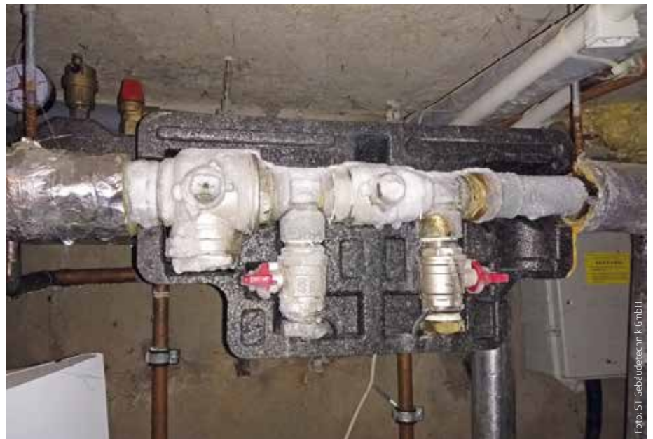
Abbildung 2: Eingefrorene Solenachspeisung
