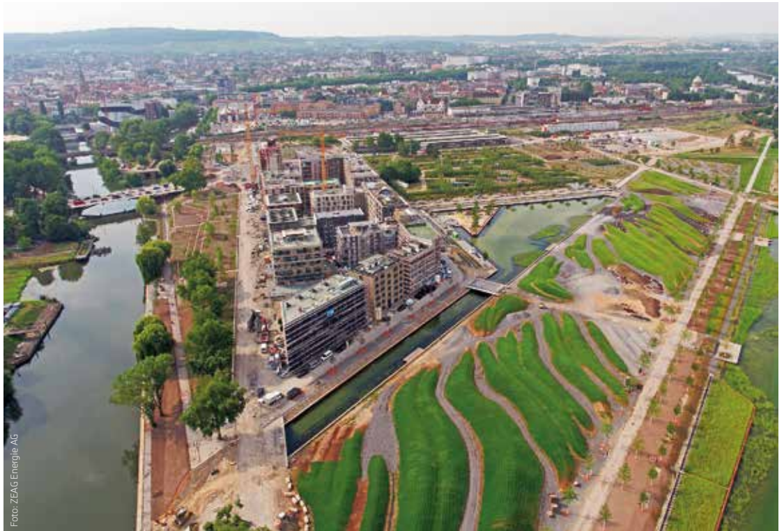
Das Stadtquartier Neckarbogen während der Bauphase. In der Umgebung entstehen die Grünflächen der BUGA 2019.
