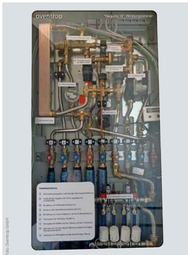
Einbausituation der „Regudis W-HTF“ Wohnungsstation mit Glasabdeckung in der Modellwohnung des SKAIO.
