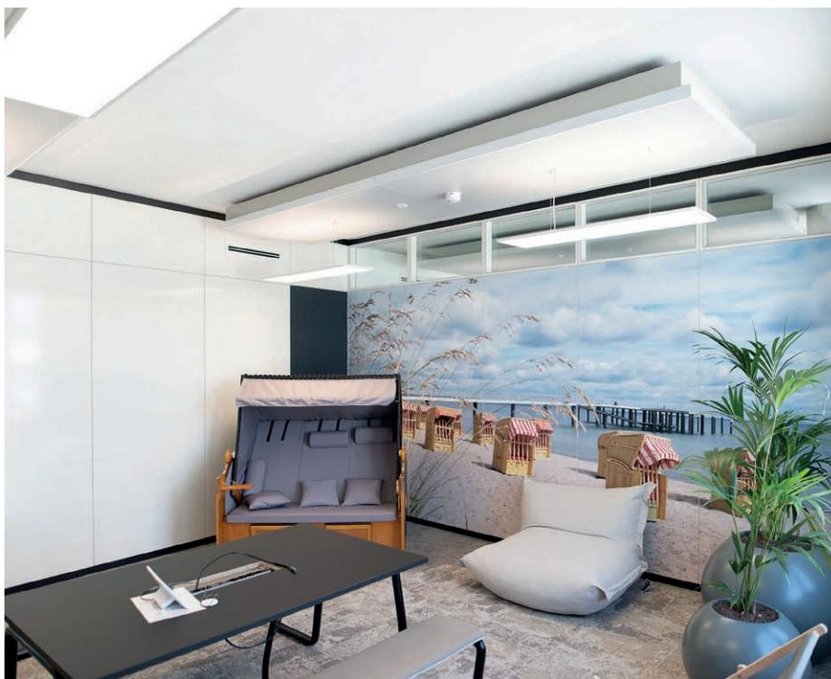
Abbildung 4: Pendelleuchten, Rauch- und Bewegungsmelder sind in die Deckensegel eingebaut.
