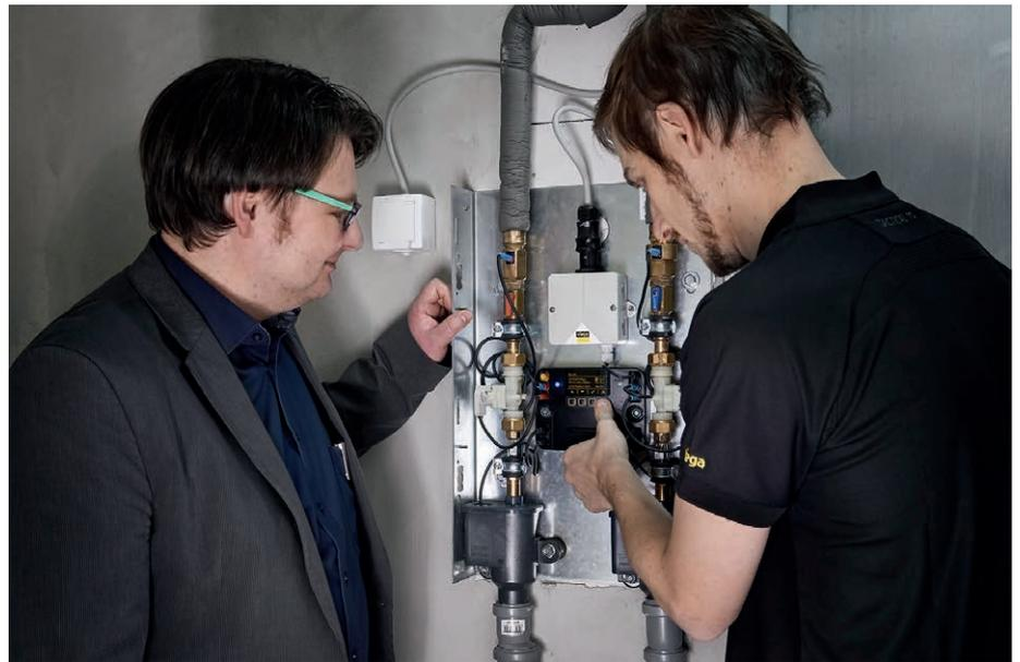
Abbildung 6: Die Installation einer Spülstation kann im Bestand erforderlich sein, um Stagnation zu vermeiden oder Trinkwasser mit Dauertemperaturen >25°C und <55°C abzuleiten. Bei einer Neuinstallation wird die Spülstation hingegen eingesetzt, um eventuellen Stagnationsrisiken zu begegnen.
