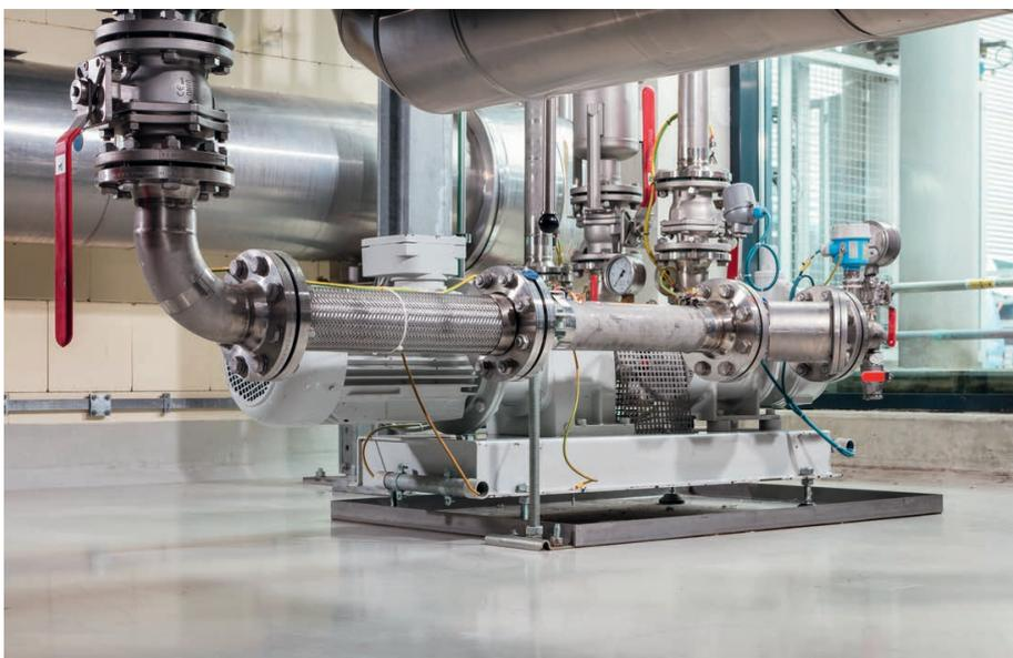
Abbildung 3: Verankerungen in WHG-Dichtfläche als Speziallösung
