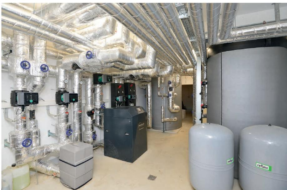
Abbildung 4: Blick in den Haustechnikraum eines modernen Mehrfamilienhauses: In den Pufferspeichern werden die Energiegewinne einer Wärmepumpe und weiterer Wärmequellen bevorratet, die dann sowohl für die Trinkwassererwärmung nach dem Durchflussprinzip als auch für Raumwärme genutzt werden können.
