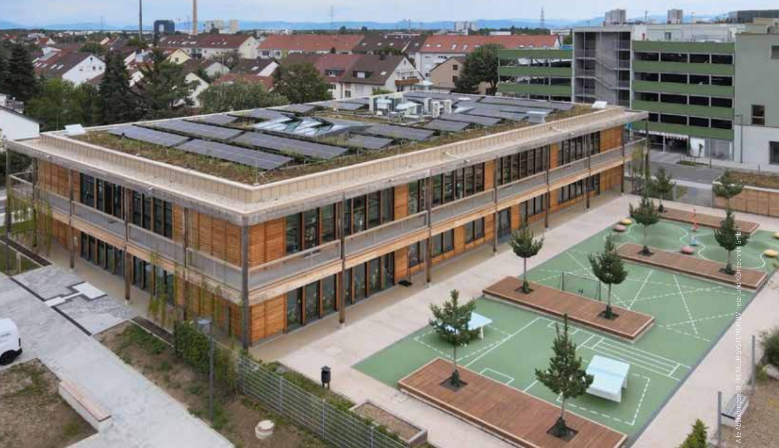
Abbildung 1: Die Holzfassade der Spinelli-Schule besteht aus naturbelassenem Lärchenholz.
