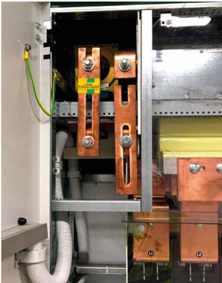
Abbildung 1: Niederspannungsschaltanlage mit ZEP und Wandler zum Monitoring
