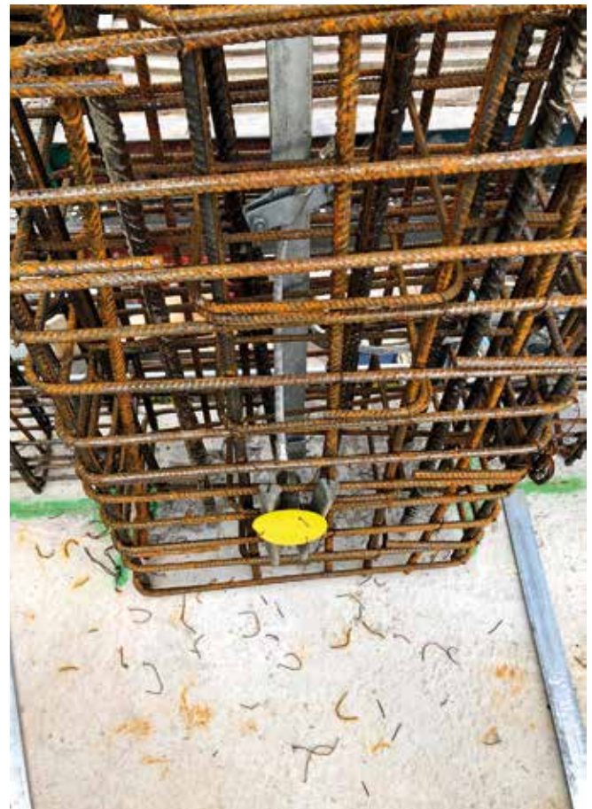
Abbildung 2: Ausführung Erdungsfestpunkt im Rohbau
