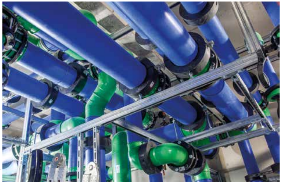
Abbildung 3: Eingesetzt wurden rund 600 Meter Rohrsystem in Rohrdurchmessern zwischen 32 und 250 mm.
