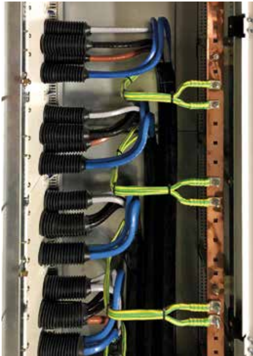
Abbildung 3: Kabelfeld mit PE-Schiene
