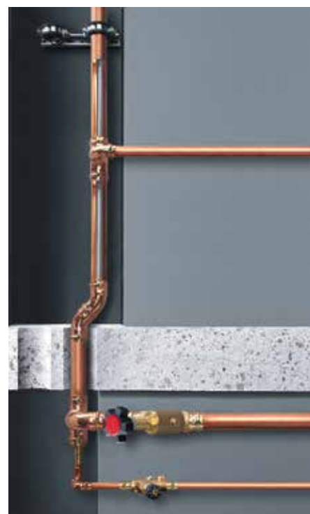
Abbildung 5: Inliner sind eine probate Möglichkeit, Abstrahlverluste in PWH-C-Installationen zu verringern und gleichzeitig den Temperaturerhalt über den gesamten Steigstrang hinweg zu unterstützen.
