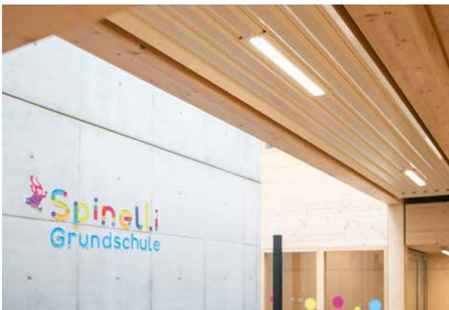
Abbildung 4: Die integrierten LED-Leuchten sparen Montageaufwand.
