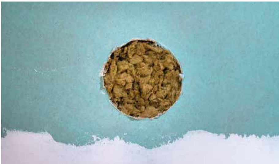
Abbildung 2: Die Hohlräume werden vollständig, mit der gewünschten Konsistenz und rauchdicht verfüllt.
