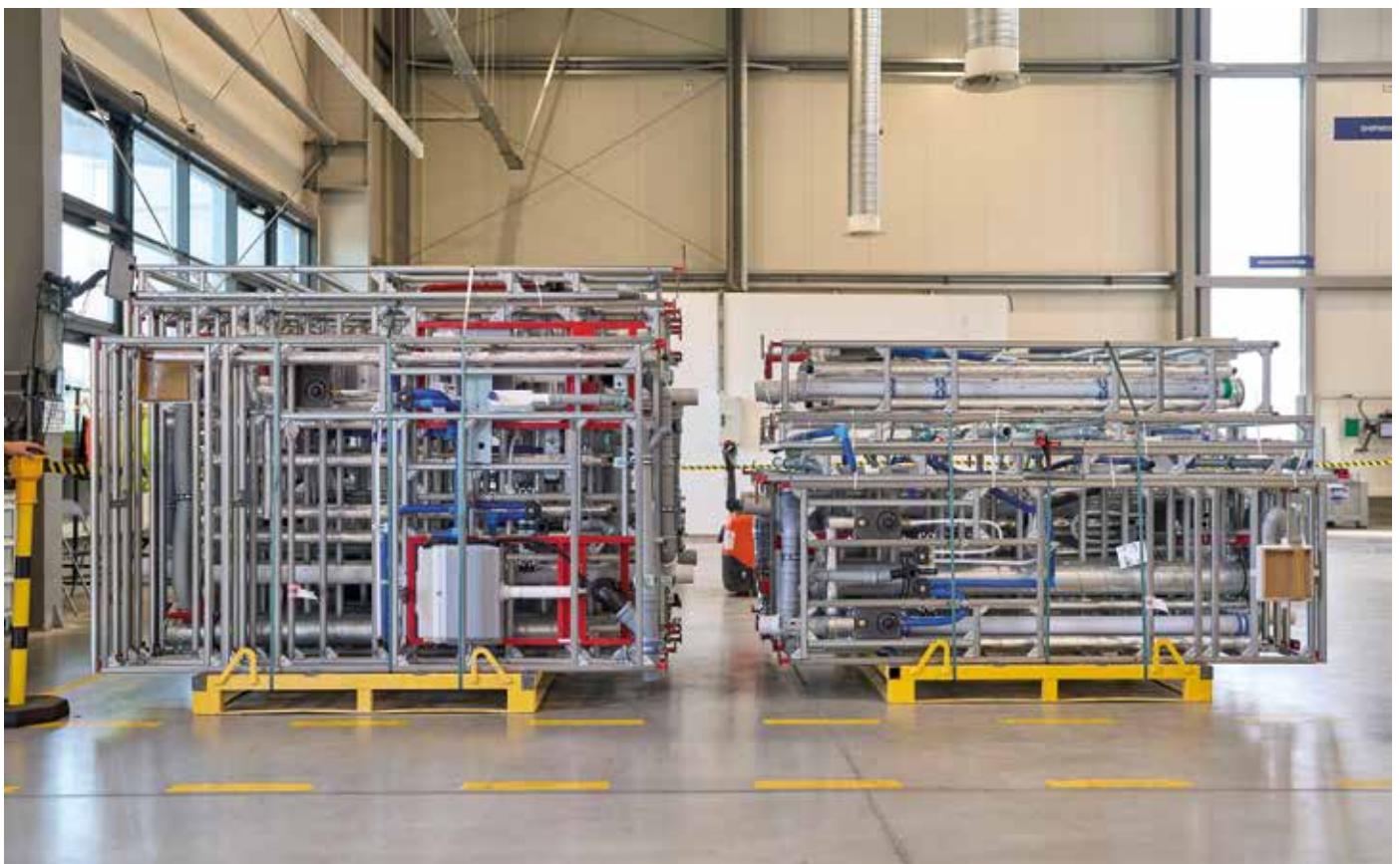
Abbildung 3: Die vorgefertigten Installationswände stehen (im Werk) für den nächsten Lieferabruf bereit.
